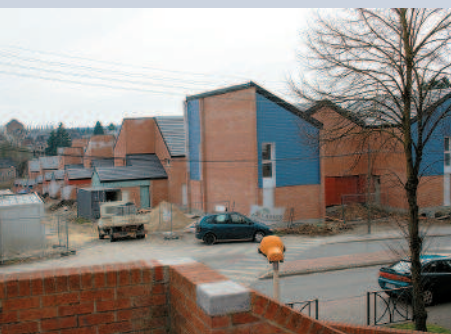
La résidence de la Filature en construction. Mairie de Fourmies, service Communication. Les 24 logements de la résidence de l'Émaillerie sont habités depuis le 25 juin. Les 16 logements de la résidence de la Filature se terminent. Les emménagements ont eu lieu en décembre 2010.
