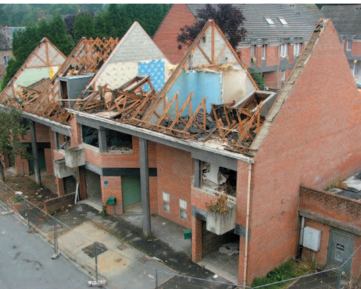
Démolition des 6 maisons en contrebas de la place Claude Jourdain, 3 juillet 2009. Sur l'emplacement dégagé, aménagement d'une place avec aire de jeux. Marie de Fourmies Direction de la Solidarité Urbaine.
