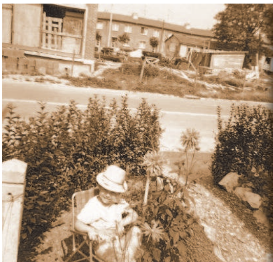
Depuis la rue Henri Dunant. Les blocs de la rue Traversière sont en cours de construction, 1966. Les 3 immeubles de la rue Traversière sont les premiers immeubles réalisés par L'Avesnoise. Coll. Pierre et Marie-Thérèse Lefebvre.
