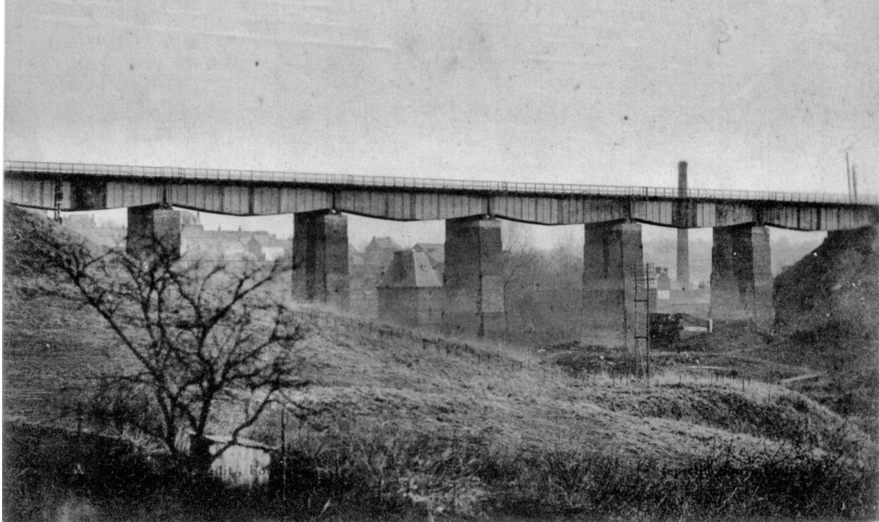
FOURMIES — Viaduc reconstruit en 1917-1918 par les Allemands
