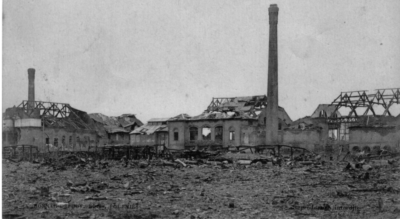
FOURMIES — Verrerie - Vue Générale, après l'Explosion
